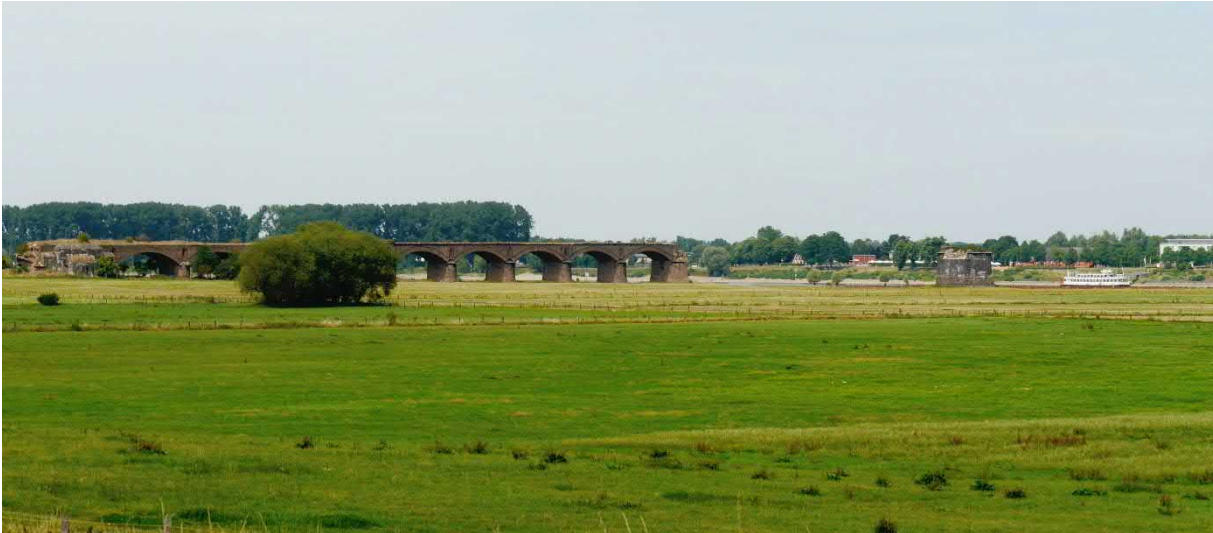
Abb. 38: Die Alte Eisenbahnbrücke im Deichvorland.
